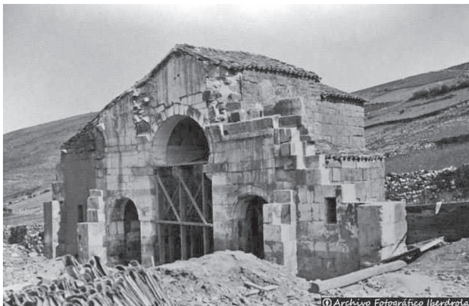
Desmontaje de la iglesia. Archivo fotográfico Iberdrola. 1930
